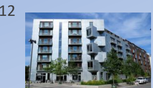
12 Kv Abisko, 213 st, 2012
