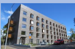
Kv Nälskäran, 135 st, 2014
